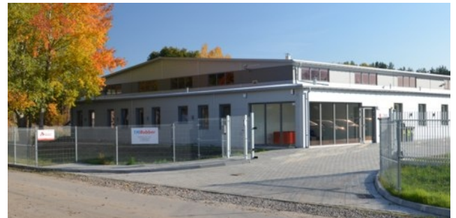
TM Rubber har helt nybyggda lokaler i staden Dobra i nordvästra Polen.
